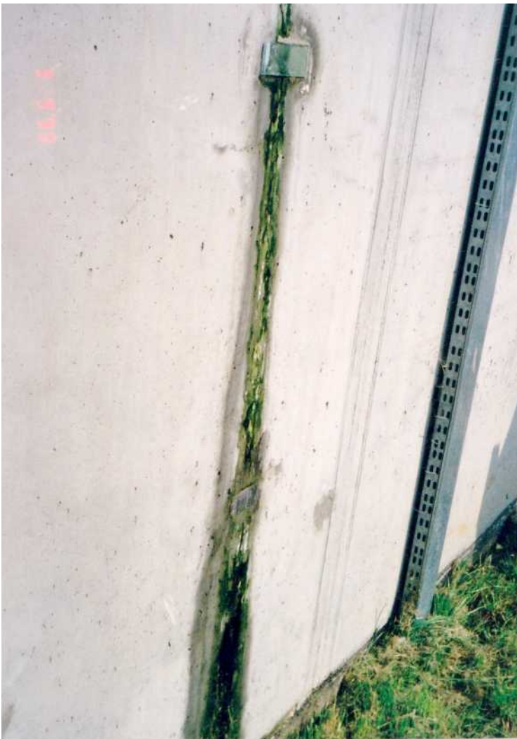
Źle wykonane żelbetonowe ściany komory biologicznego oczyszczania. Fot. powyżej: pęknięcie ściany wewnętrznej z przeciekami (czerwiec 1999 r.). Fot. poniżej: pęknięcie ściany z silnym wyciekami na zewnątrz (wrzesień 1999 r.).
